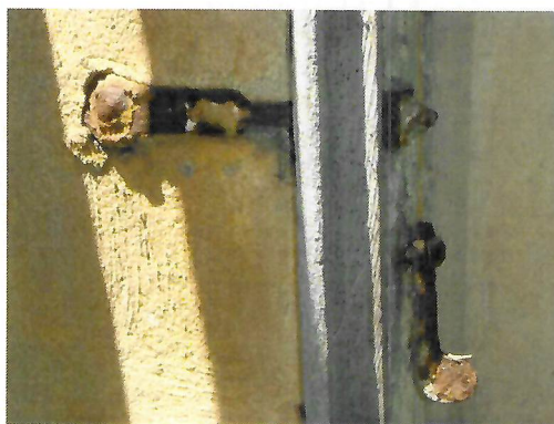
DETAIL KOTVENÍ DO DŘEVĚNÉHO HMOŽDÍKU VE VNĚJŠÍM OSTĚNÍ A JEDNOSTRANNÉHO OBRTLÍKU NA VNĚJŠÍM RÁMU
